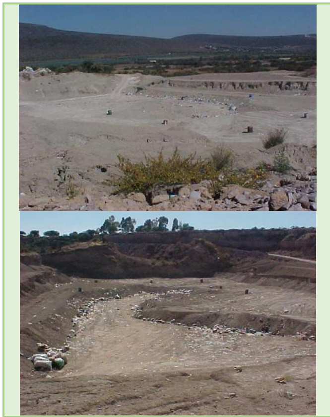
Figura 12. Relleno sanitario después de un día de trabajo.
