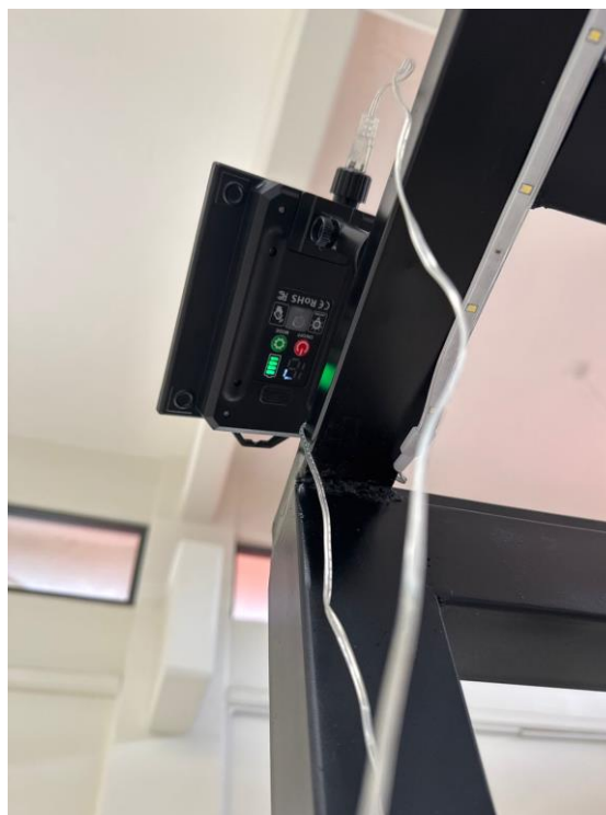
Figura 5. Colocación de tira led con panel solar
