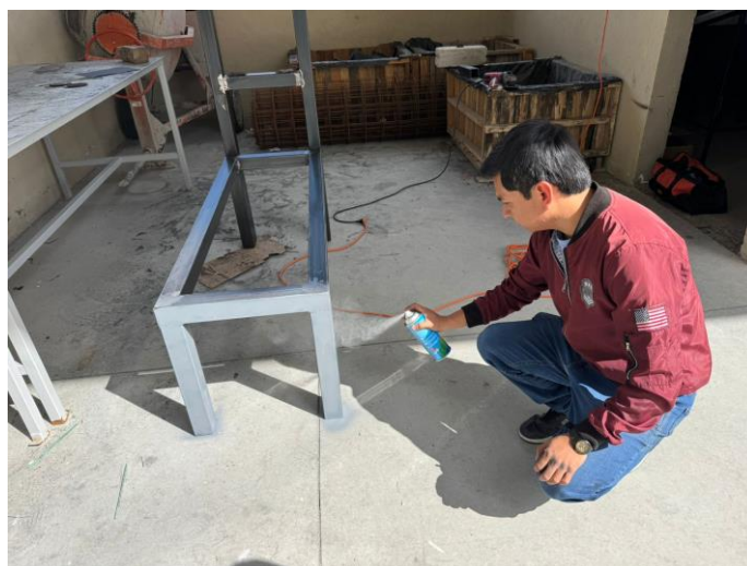
Figura 3. Aplicación de primario en estructura de acero
