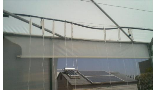
Figura 6. Sistema fotovoltaico del invernadero tipo tunel. Fuente: elaboración propia.
