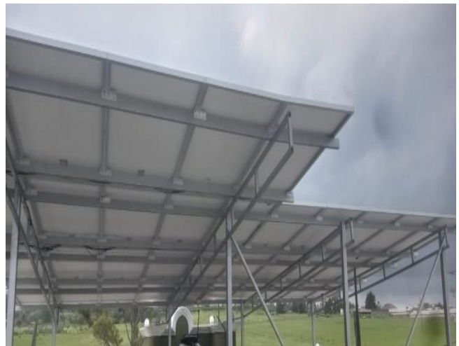
Figura 9. Instalación de paneles en la azotea. Fuente: elaboración propia.
