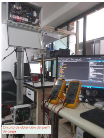
Figura 12. Nodo sensor conectado al circuito de obtención del perfil de carga. Fuente: elaboración propia.
