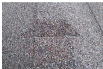
Fig. 9. Brecha en la corona de la presa.
